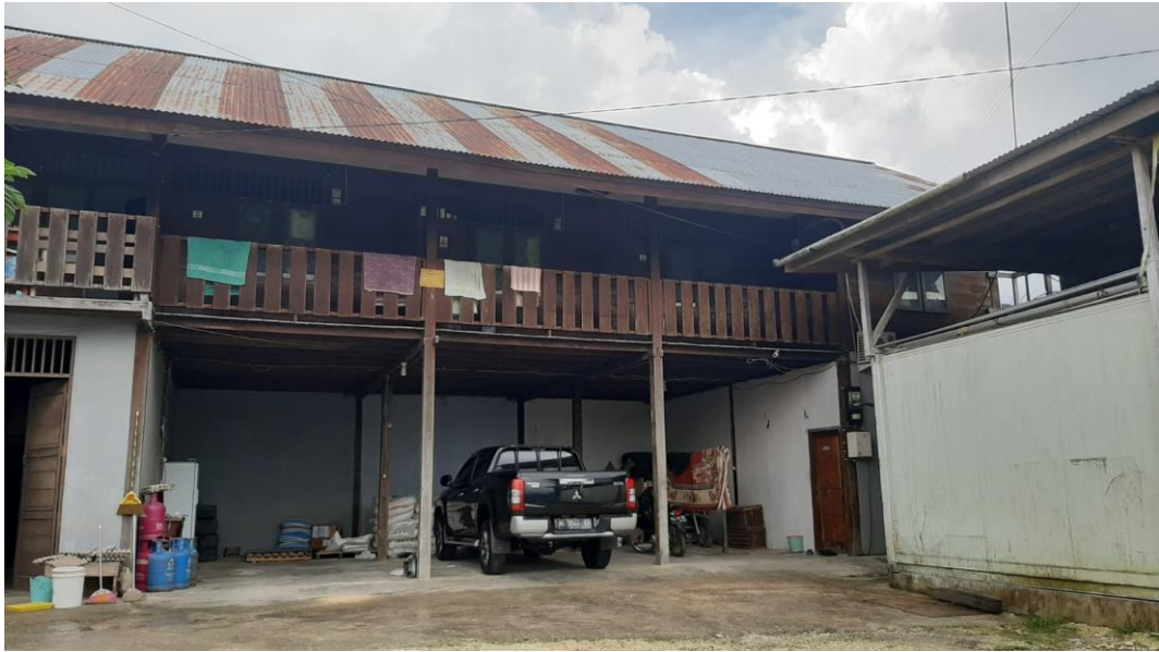
Gambar 1 : lokasi kantor PT. Pelabuhan Wapnor Biak
